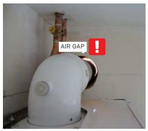
**BOILER FLUE NOT SEALED**
